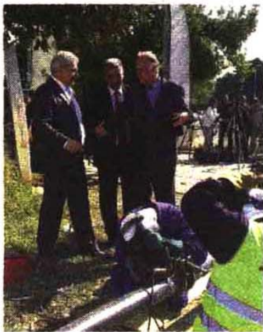
VELIKI POSAO Otvaranje radova
